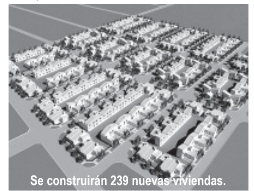
Se construirán 239 nuevas viviendas.
